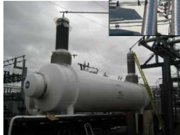
115 кВ ограничитель тока повреждений от AMSC, Siemens
